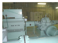
原子炉補機 冷却水ポンプ
