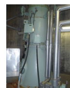
原子炉補機冷却 海水ポンプ
