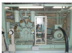
計装用空気圧縮機
