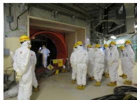
写真2 5号原子炉建屋機器搬入口前
