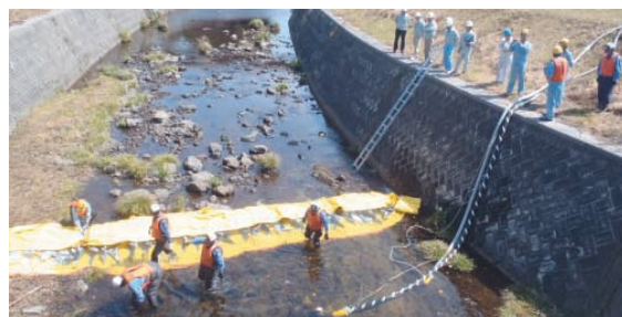
図4：渇水時を想定した河川の堰き止めおよび取水訓練
