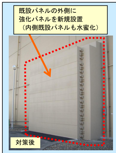
建屋外壁の二重化 （強化パネルの新規設置）
