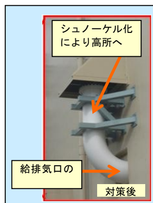
空調用換気口の高所化
