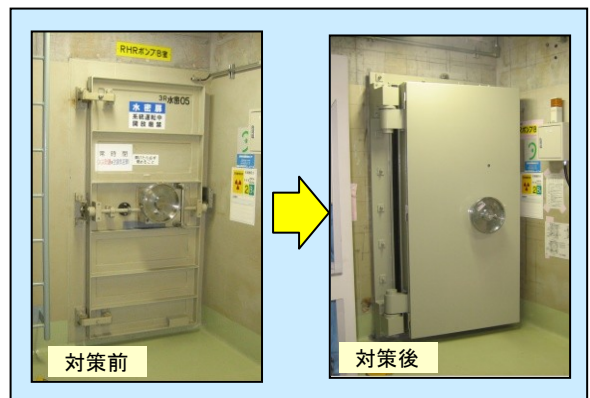
建屋内機器室の扉の水密化
