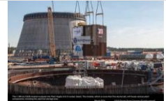
ボークル3号機 大型モジュール搭載 (2014年3月)
