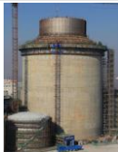
三門1号機 PCSタンク設置 (2014年3月) PCS: Passive Containment Cooling System
