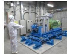
蒸気発生器直接給水用高圧ポンプ
