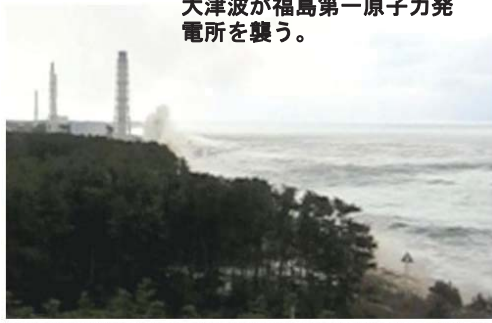
福島第一原子力3・4号機の排気筒（左から3本目、高さ約120メートル）に迫る大津波（3月11日撮影、東京電力提供）
